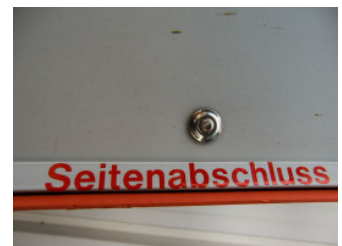
- Bild 3g - Seitenabschluss mit Ortgang und Spenglerschraube am Ende des Daches / 60cm-80cm Verschraubungsabstand
