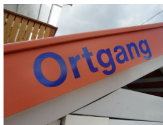
- Bild 3f - Ortgang mit aufgedrücktem Dachbahnenprofil
